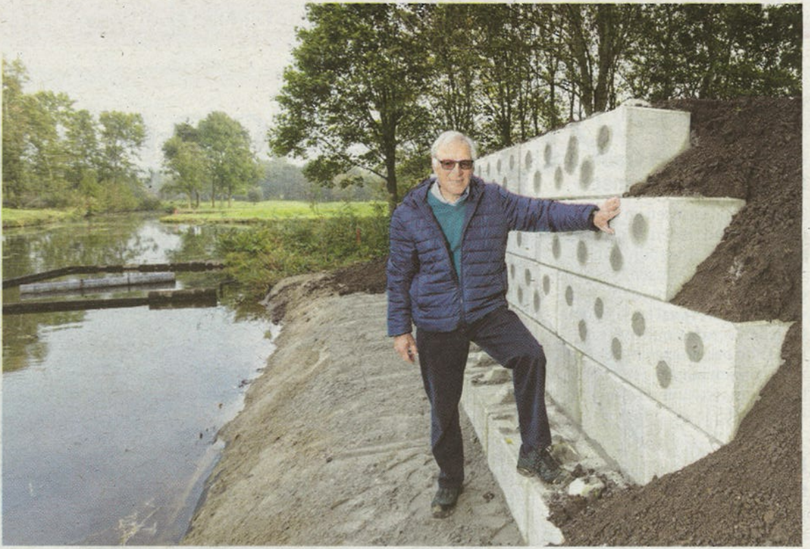
▲ Initiatiefnemer én golfer Jan Bouwhuis bij de nieuwe oeverwalwand. FOTO PETER FRANKEN
